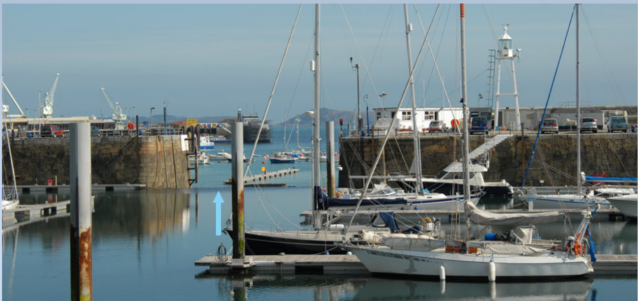
St. Peter Port, Guernsey. - O Schreck, das Wasser ist weg! Genau hinschauen: der Pfeil markiert einen schwachen Schatten. Dort befindet sich ein Drempel, danach geht es 3 m abwärts. Für Spätankommer gibt es draußen einen Warteschlengel.
